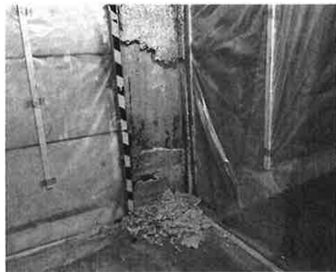
「JP-010」を噴霧し、自然落下するアスベスト
